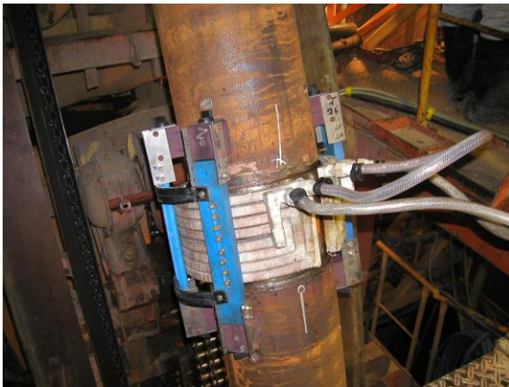
写真1. SMA継手による曲線鋼管の接続 7)
