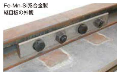
Fe-Mn-Si系合金製継目板の外観
